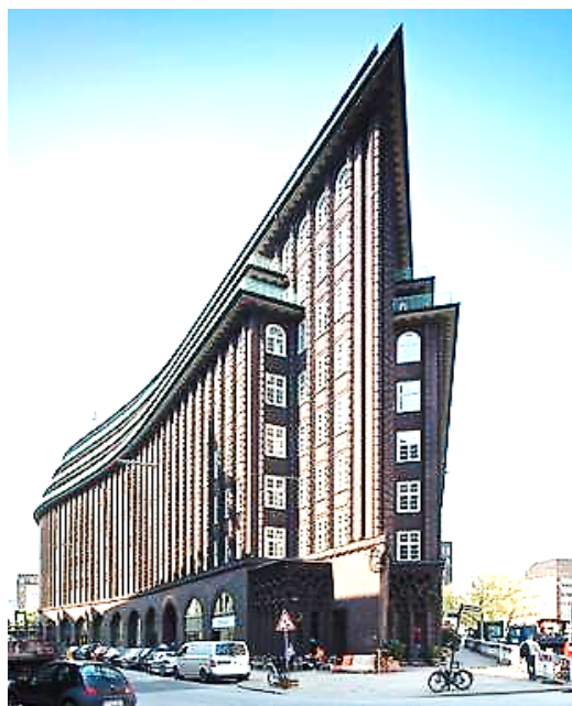
Chilehaus. Hamburgo. Fritz Höger (1923)
